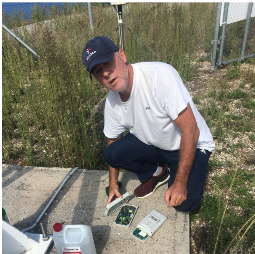
Απο τις τεχνικές εργασίες στον σταθμό CRF-1 (25/9/2020).
