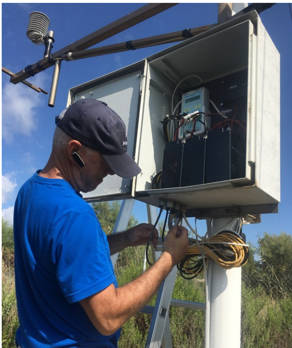
Απο τις τεχνικές εργασίες στον σταθμό CRF-3 (24/9/2020).
