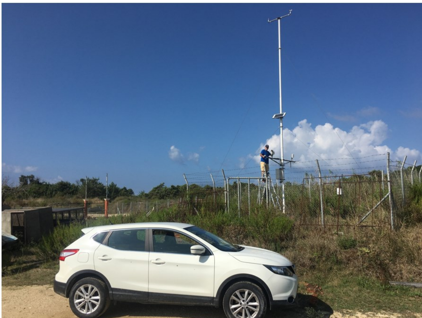
Απο τις τεχνικές εργασίες στον σταθμό CRF-3 (24/9/2020).
