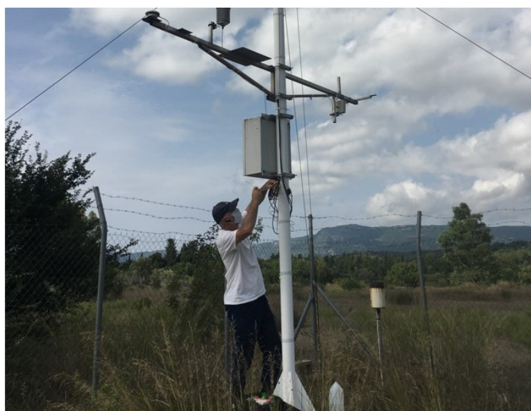
Απο τις τεχνικές εργασίες στον σταθμό CRF-2 (25/9/2020).
